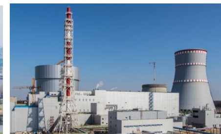
Россия, Ленинградская АЭС-2, Блок 1 - 1200 МВт
