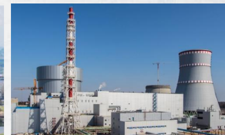
Россия, Ленинградская АЭС-2, Блок 1 - 1200 МВт
