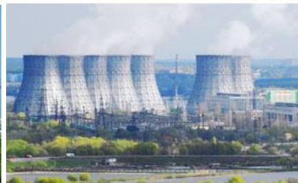
Россия, Нововоронежская АЭС-2, Блок 1 - 1200 МВт
