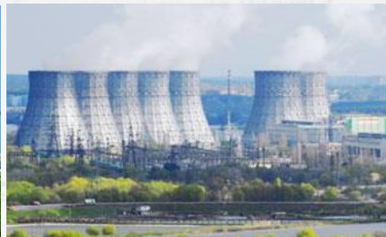
Россия, Нововоронежская АЭС-2, Блок 1 - 1200 МВт
